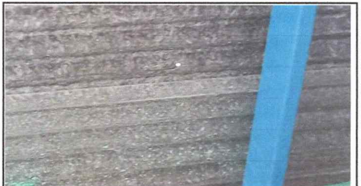
Laminas con agujeros goteando durante la tormenta y durante los inviernos.
