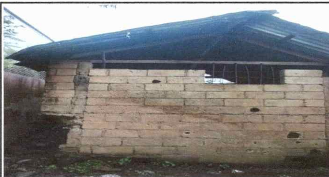
Techo de cocina dañado en su totalidad por tormentas y vientos.
